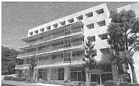
写真1：生物工学国際交流センター
